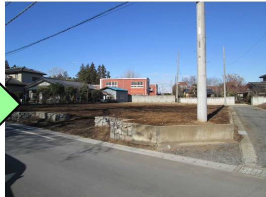
〔解体撤去補助制度の活用による解体〕
