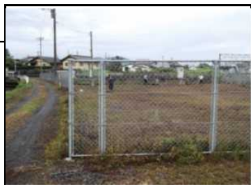
<機場の点検・周辺の草刈>
