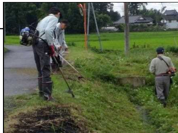
用水路の草刈り
