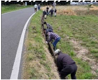
用水路の泥上げ
