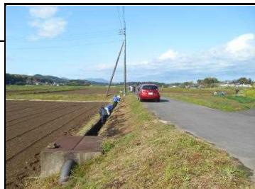
用水路の土砂上げ作業
