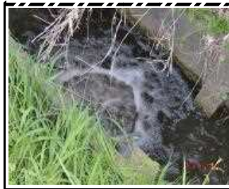
いつ:4月 用水機場(ポンプ)給水槽の泥上げ。
