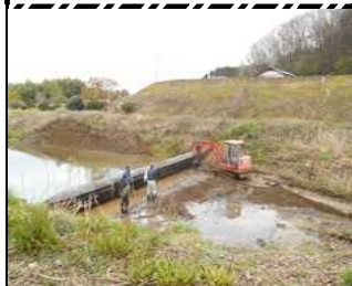
取水口土砂払い作業
