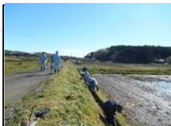
用水路泥上げ作業
