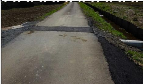
敷設されたコルゲート管の腐食によりヒューム管への交換工事を実施。
