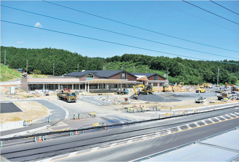
建設中の道の駅かさま（7月19日撮影）
