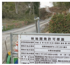
飯田地区太陽光発電建設現場入口
