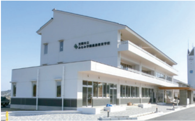
増築された校舎
