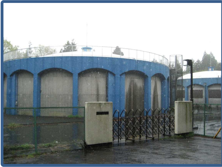
箱田配水池 【P C造 2,500m 3 ×2基】
