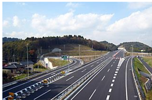
北関東自動車道
