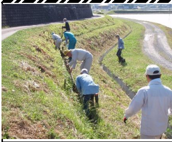
水路の泥上げ
