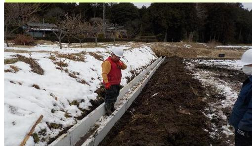
平成30年1月28日敷設完了。2月14日U字溝両脇の隙間の埋め戻しを実施し最終完了。
