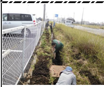
U字溝の泥上げ
