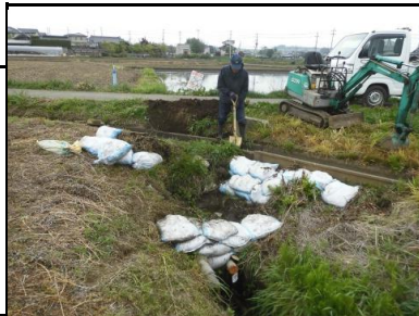
土のう袋で土盛り
