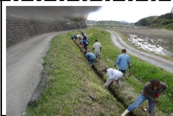
水路の泥上げ
