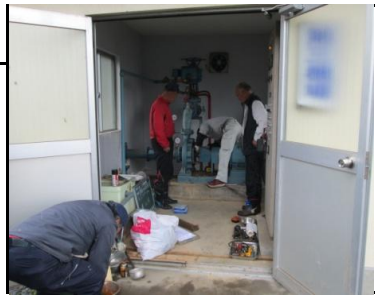
機場の操作点検及び送水管点検
