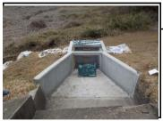
いつ:昨年12月~2月 ため池余水吐きの落水 口が浸食により崩れか かっていたため、長寿命 化交付金により桝を設置 し浸食の防止を図りまし
