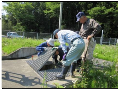
ため池の点検
