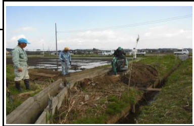
水路法面修復
