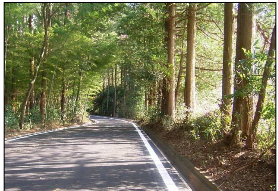
舗装された林道本戸前山線
