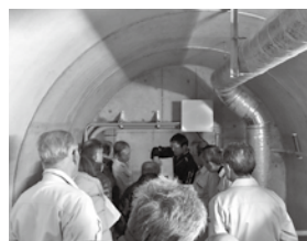
アーチカルバート （浸出水導水路）の監視状況
