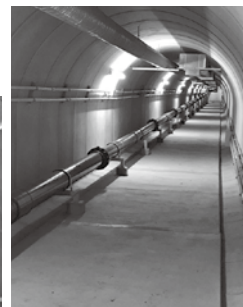
アーチカルバート （浸出水導水路）
