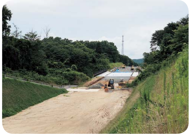
国道355号笠間バイパス手越跨線橋付近（H30.7.7 撮影）
