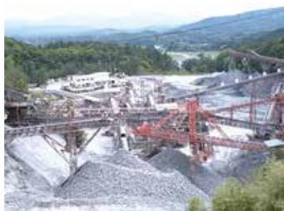
プラントの様子
