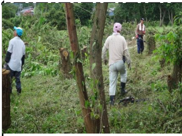
暑い中の伐採作業
