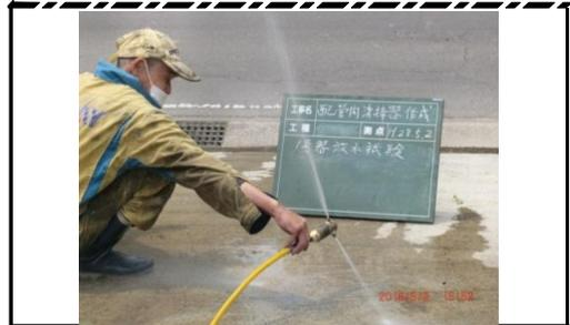
パイプラインの内部洗浄、清掃のため高圧噴霧器を改良し清掃機械を製作した。これによりパイプラインの内部に付着したヘドロの除去が可能となった。
