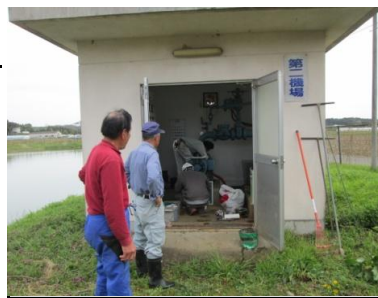
機場の操作点検及び 送水管点検
