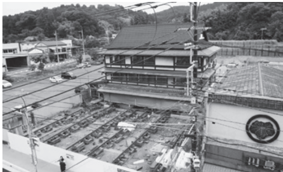
曳家直後の旧井筒屋
