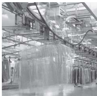
作業場内の様子
