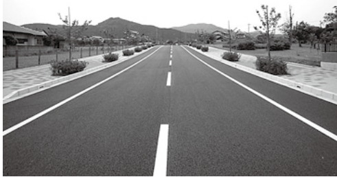
一部供用開始した岩間駅東大通り線
