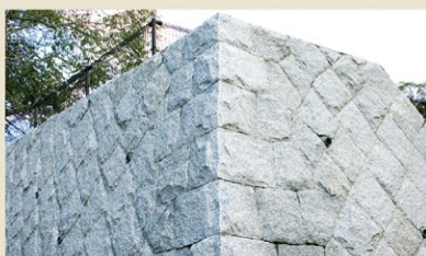
間知石を一つひとつ 丁寧に積み上げた擁壁
