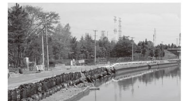
車が通れるまでに復旧した道路
