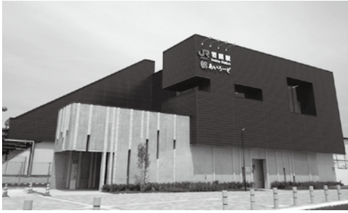
岩間駅駅舎・自由通路完成
