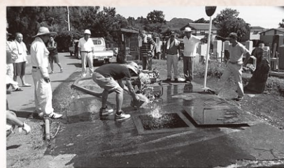
資機材の点検
