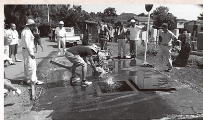
資機材の点検
