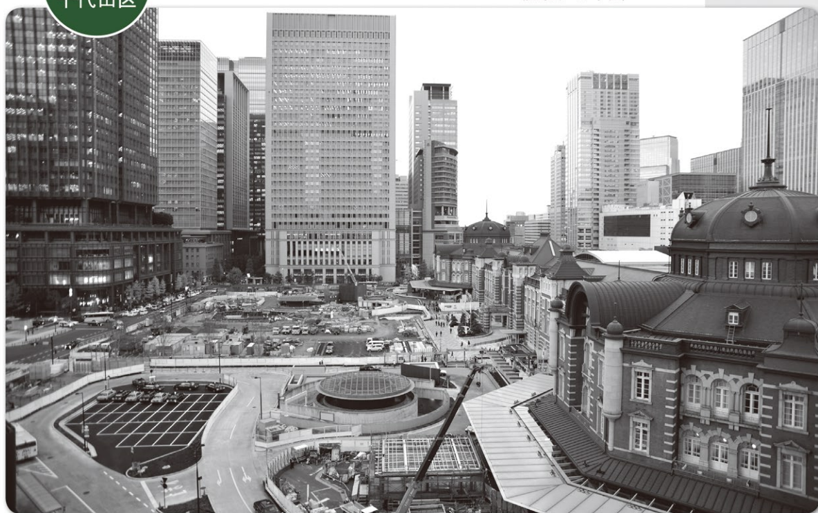
▲東京駅丸の内駅前広場再開発の様子
