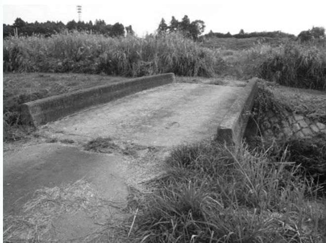
行き止まりとなっている安戸地区の市道
