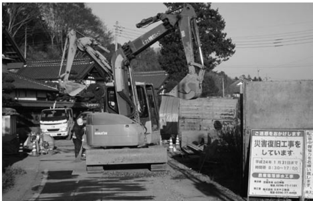
市内各所で災害復旧工事が進められています
