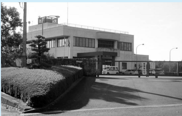
県広域水道の潤沼川浄水場
