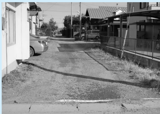
改良が待たれる未整備の生活道路
