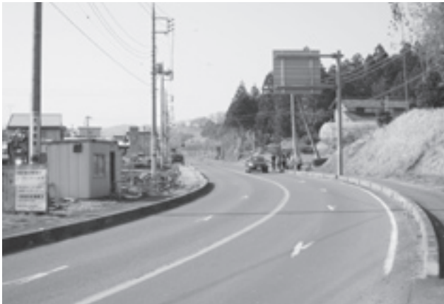
ギャラリーロードの排水整備工事
