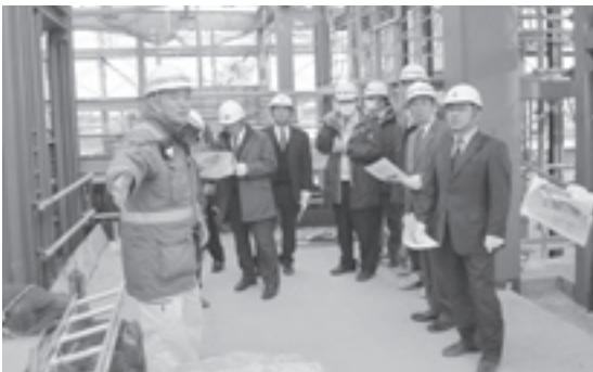
岩間橋上駅舎の進捗について説明を受ける委員
