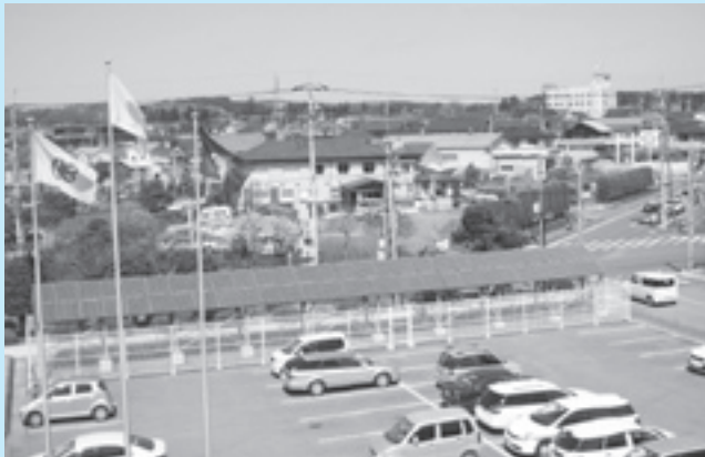
本庁舎駐車場に設置した太陽光発電
