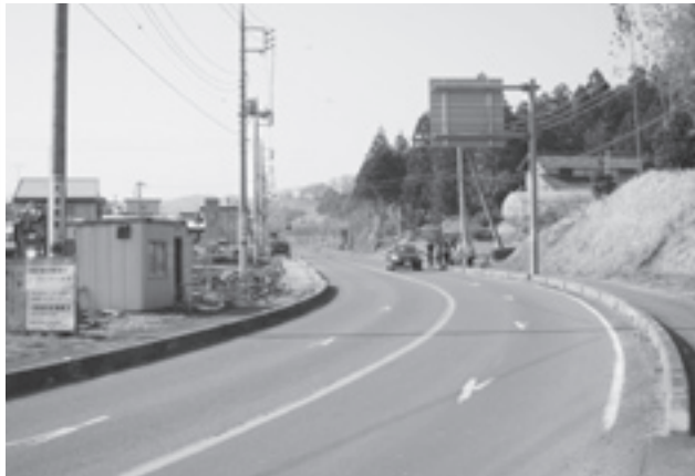
ギャラリーロードの排水整備工事
