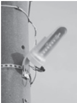
電柱に設置された共架式LED防犯灯
