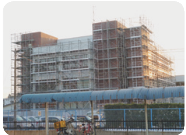
耐震補強及び災害復旧工事が進む友部公民館
