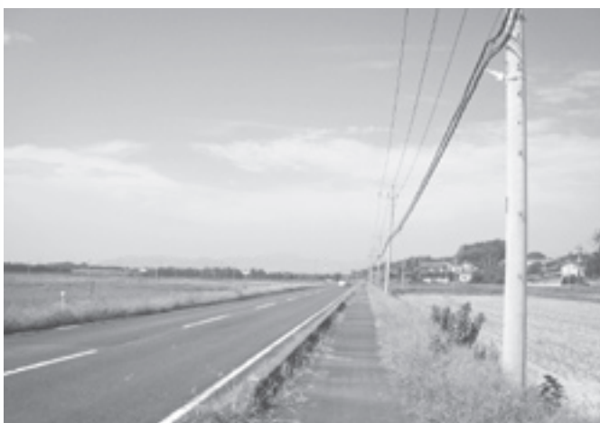
LED化された防犯灯
