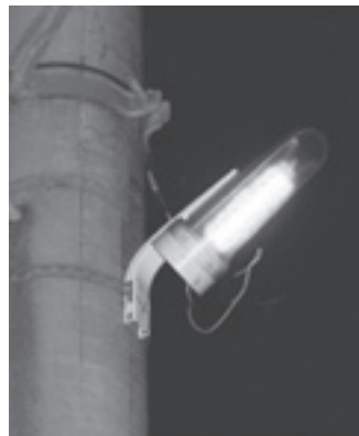
電柱に設置された共架式LED防犯灯
