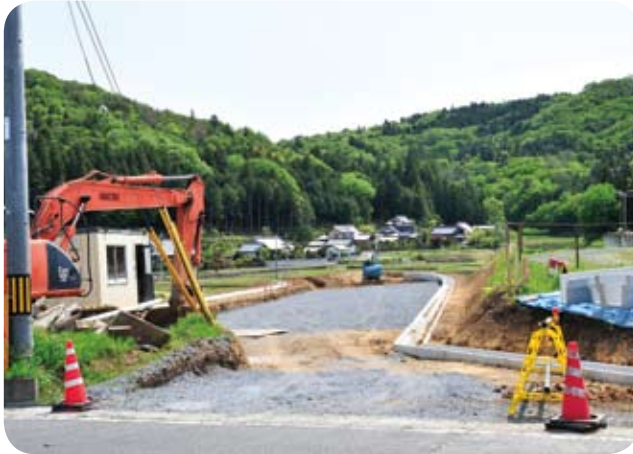
国道 50 号 稲田・飯合間のバイパス機能が期待される、来栖本戸線 (L=3,200)、大古山地区 (H25.5.9)
