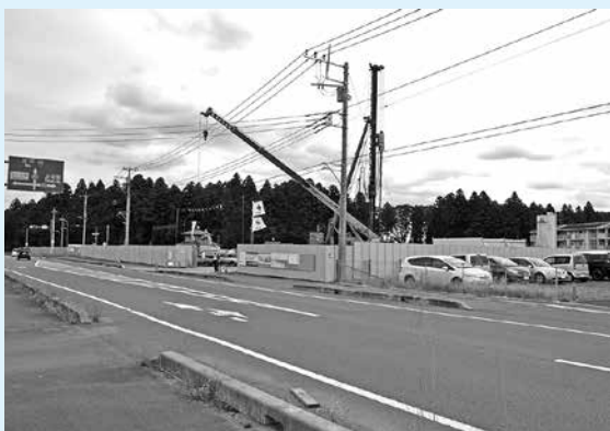
特養施設の隣地に建設中の市立病院
