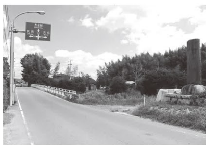
涸沼川改修記念碑（右）と 欄干の補修工事を終えた穴戸橋
