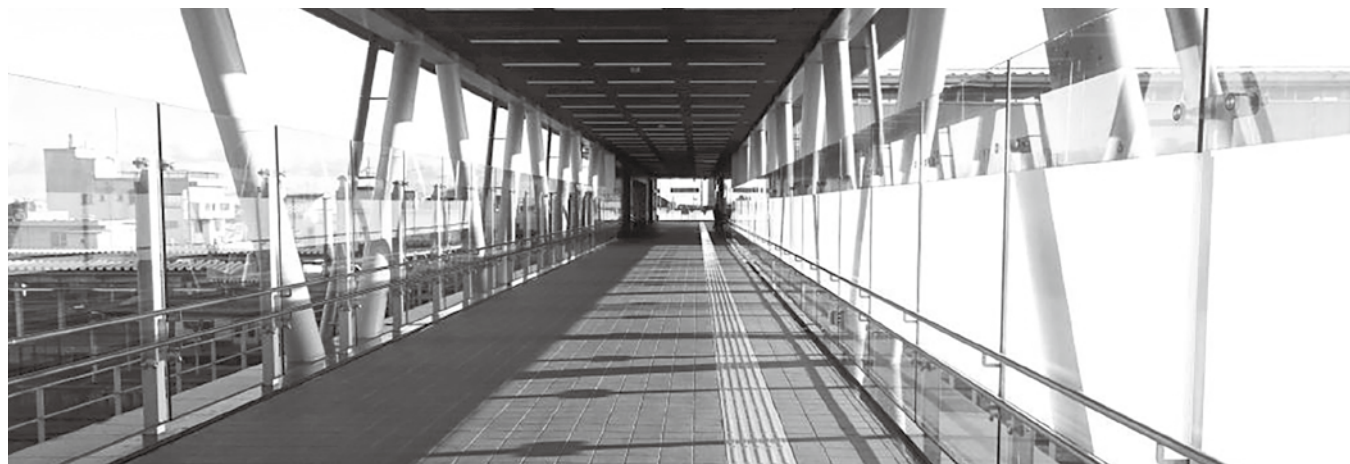
パネルを設置予定の友部駅南北自由通路
