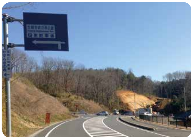
北山公園内を通過する南友部平町線の工事が進んでいます。(H28.1.28 撮影)
