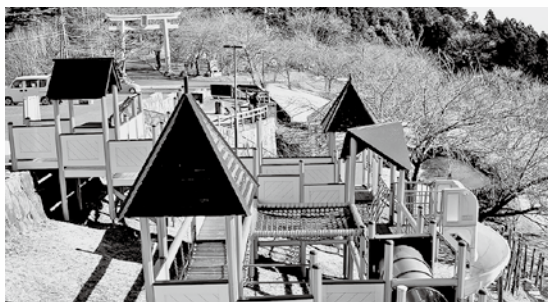
修繕が終了した遊具
