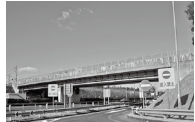
橋梁長寿命化に基づき実施される 市内全体の橋の点検・修繕
